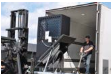
Verladen der vorgefertigten Einheiten.
