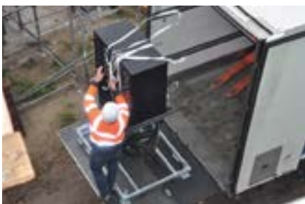
Abladen direkt auf der Baustelle.
