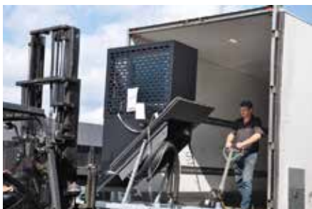
Laden van de Prefab-units
