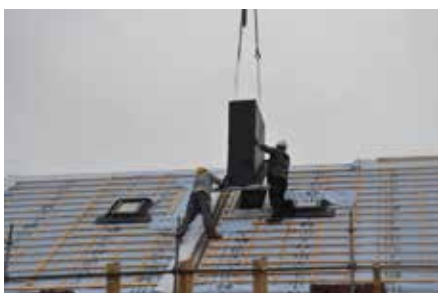
Afwerking op het dak en aansluiting binnenshuis.
