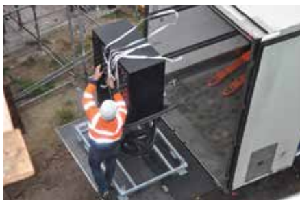
Lossen rechtstreeks op de bouw
